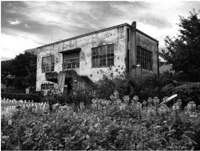
空襲の傷跡が残る旧日立航空機株式会社変電所
