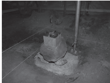
柱礎石据付高さ、通りの調整作業
