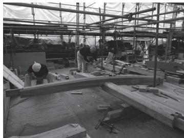
とばでいの梁行・桁行梁仮組み作業
