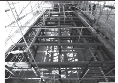
小屋梁までの軸部組立て作業
