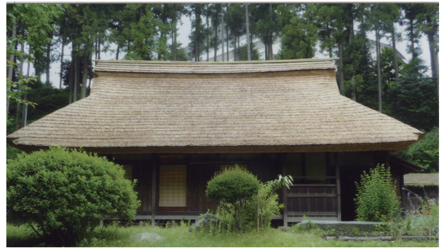
工事後の「旧宮崎家住宅」
