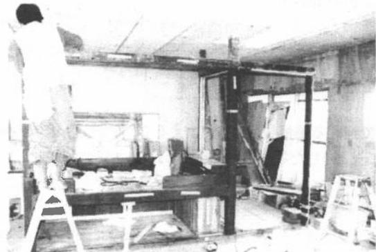
復元する場所に柱や鴨居、敷居などの主要な部材を組み立てます。骨格となる部材が組みあがったら復元するレベルにあわせ高さを調整します。
