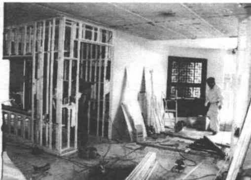
骨格となる木部にあわせて壁の下地を組みます。チリなども部材の痕跡を手がかりにします。下地と平行して建具などの部品をはめ込んでいきます。
