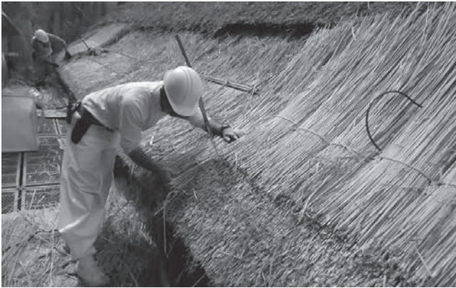
修復作業の様子
