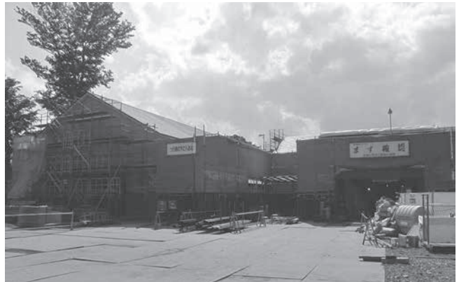
建設中の郷土資料館
