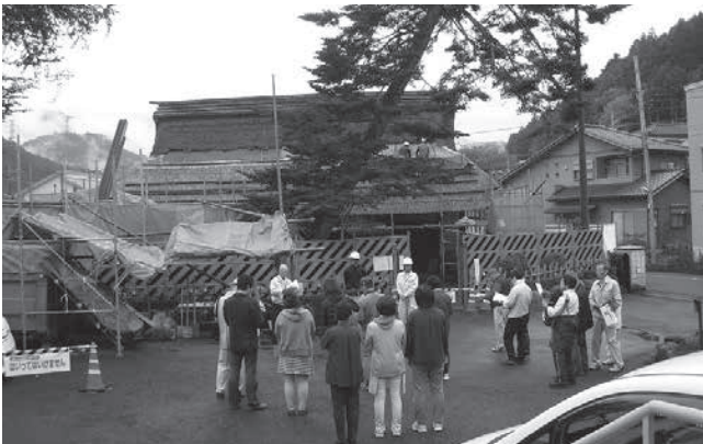
修復作業現地説明会の様子
