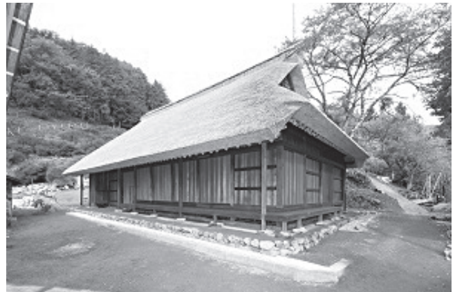
廻り廊下は、雨戸の外側に設置されており、当時の建築様式がうかがえる。
