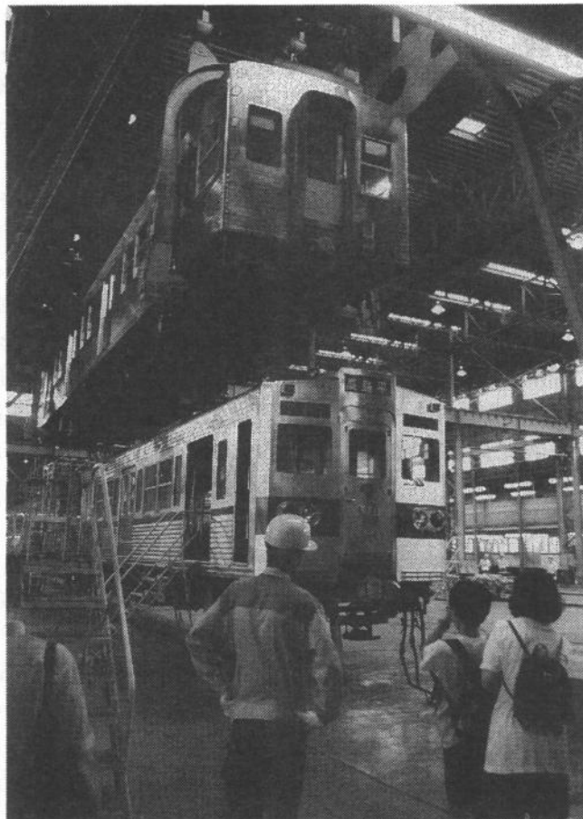
志村車両基地見学会、30トンクレーンによる車体吊上げ作業
